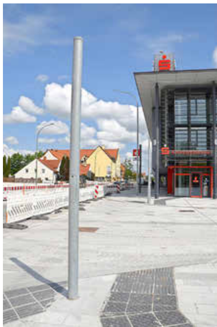
Die Masten stehen – wie zum Beispiel an der Einmündung Marktstraße. In den nächsten Wochen werden hier die Ampeln angebracht.
