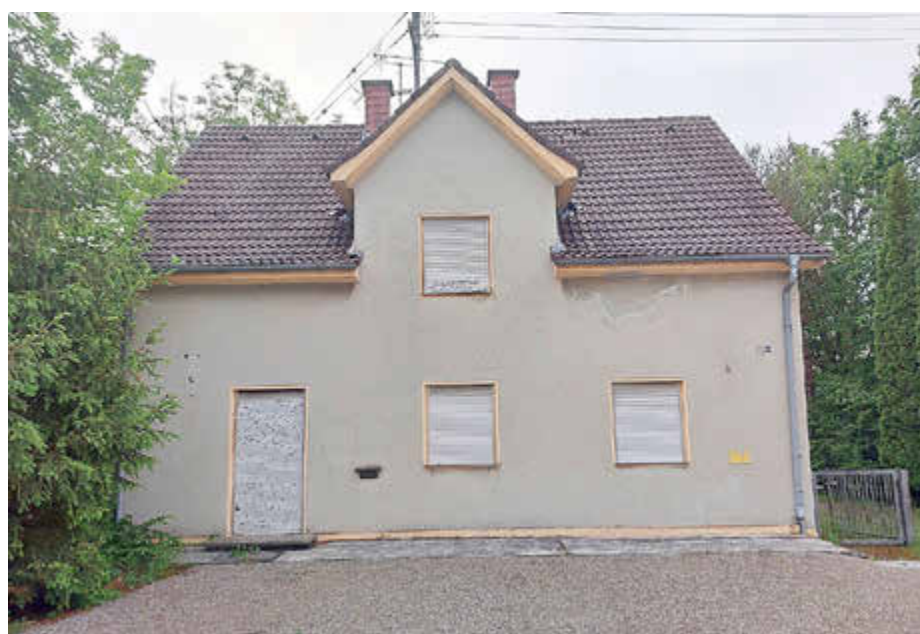
Das Gebäude an der Bürgermeister-Wohlfarth-Str. 63 heute! Foto: Markus Wiedenmann
