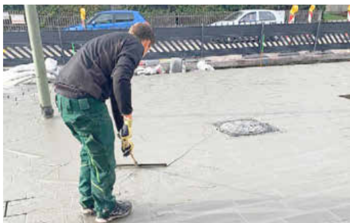
Im ersten Bauabschnitt laufen die Verfugungsarbeiten.
