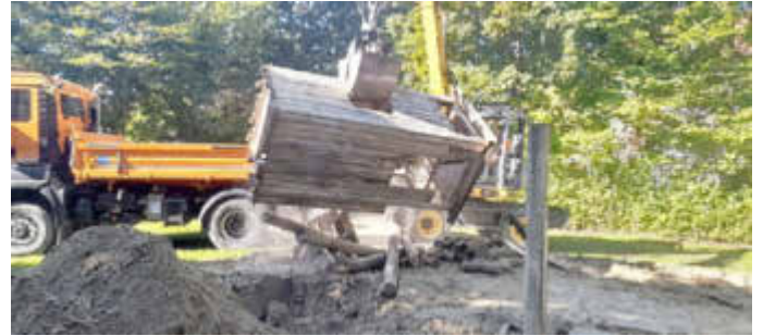
Der alte Spielurm hat ausgedient, ... bald wird auf dem Spielplatz in der Simpertstraße ein neuer Turm stehen! Foto: Stefan Speer
